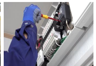
ご家庭の電気設備の点検
