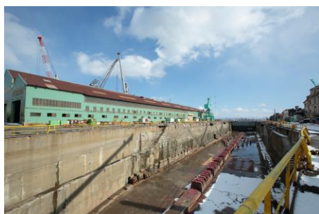
修繕船ドック（1号ドック）
