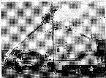
高所作業車によるトランス新設工事
