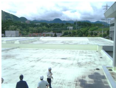
白川浄水場防水工事施工前
