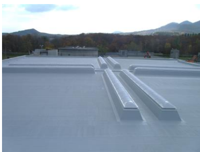
同浄水場防水工事施工後
