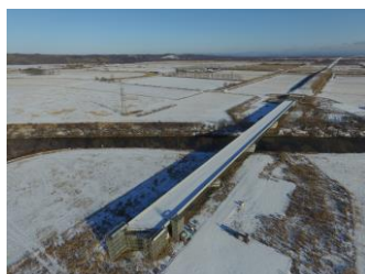
道東自動車道橋梁工事
