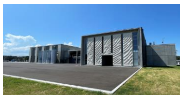
福島RDMセンター研究棟
